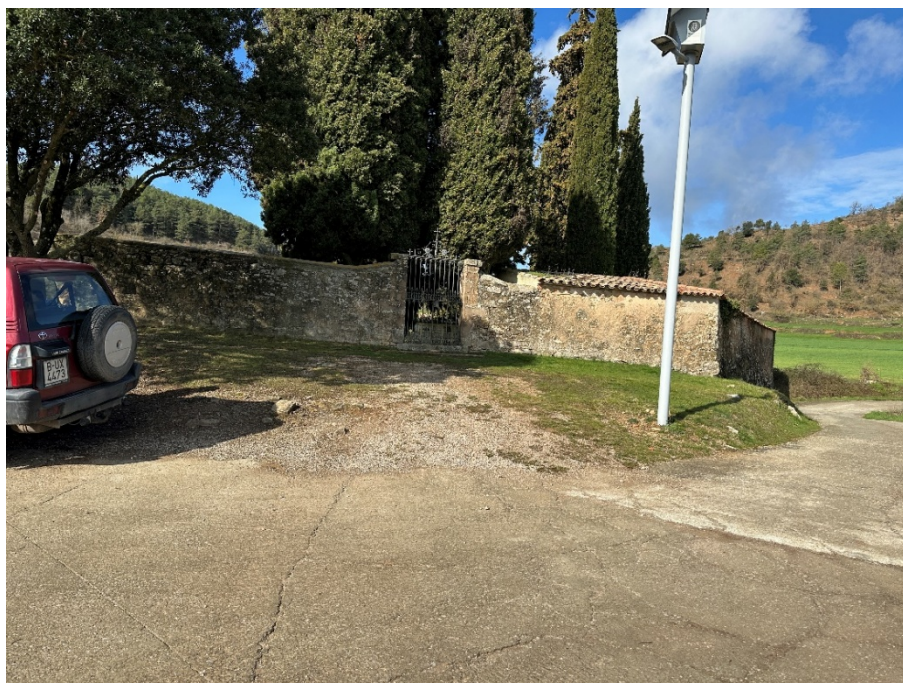
Vista des de Camí de la Crossa
